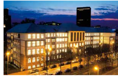
Seit der Renovierung 2002 strahlt die Gutenbergschule im neuen Glanz.
